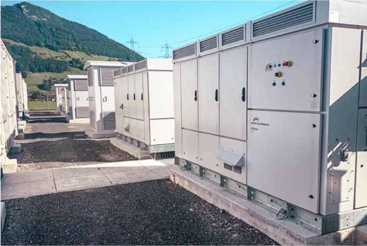
Transformatorgehäuse mit Schwenkgriffen, Mehrpunktverriegelungen und Sonderdichtungen von EMKA. Eine saubere und nachhaltige Welt für zukünftige Generationen: Das ist die Vision von Power Electronics.
